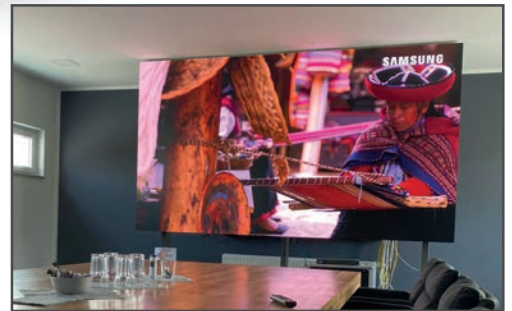
Beispielinstallation: Bolt-Down, Showroom M-Medientechnik / Samsung The Wall
